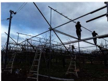
棟パイプ設置状況
