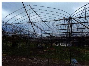
アーチ設置状況
