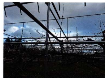
アーチ設置状況
