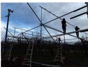
棟パイプ設置状況
