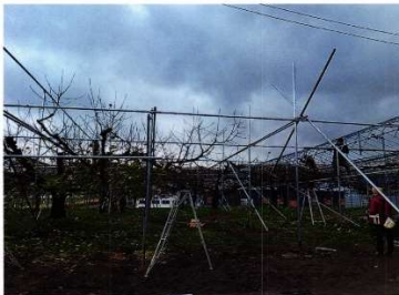
筋交い設置状況
