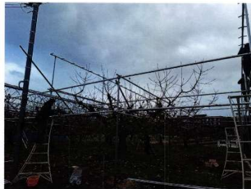
柱・梁設置状況
