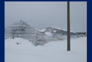
パイプハウス倒壊（川西町）
