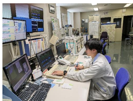
場内設備の運転状況・水質確認
