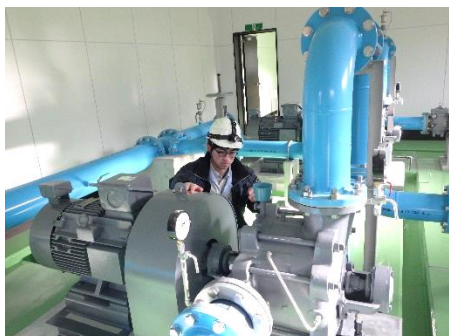
工事監督の様子
