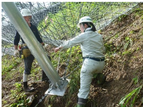
施工管理の様子
