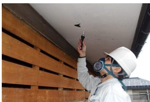
アスベスト含有調査の様子
