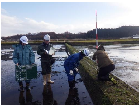
工事検査の様子
