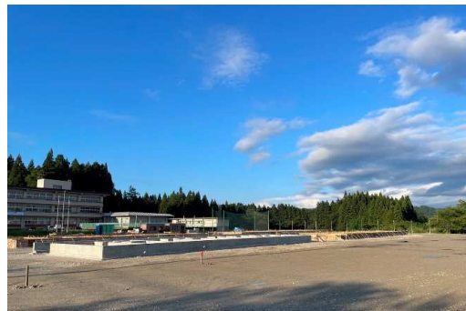
R6.9.3 基礎工事完了
