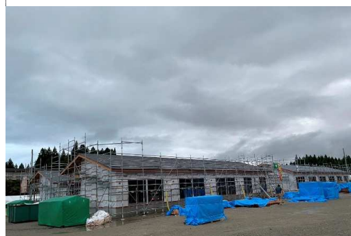
R6.9.15 外装、内装工事中
