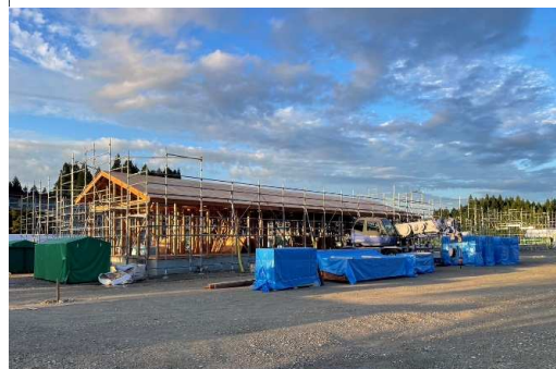
R6.9.8 建方完了
