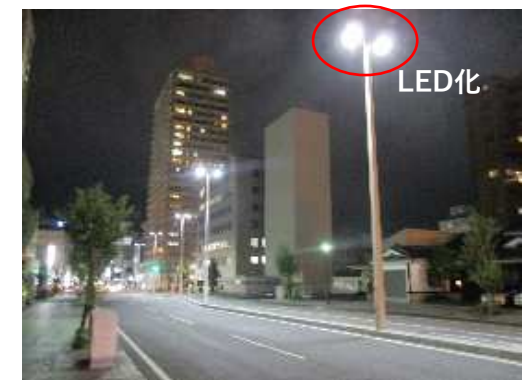
県内 道路照明LED化
