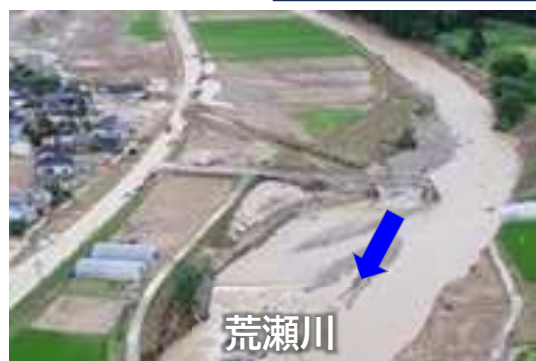
浸水被害(令和6年7月)
