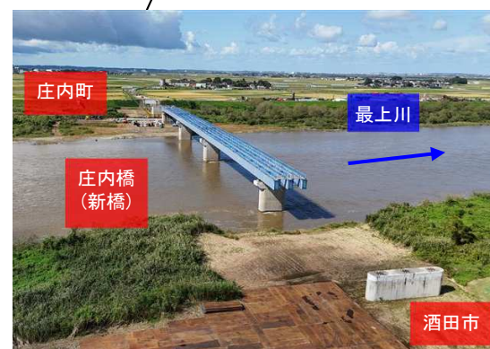
(一)余目松山線（庄内橋）
