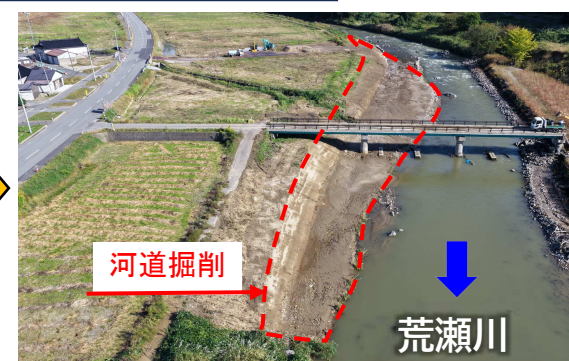
河道掘削工事
