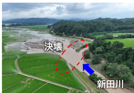
堤防決壊(令和6年7月)
