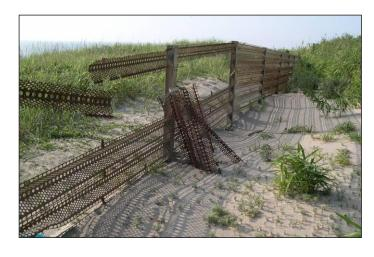
写真62 埋没し破損した鋼製折板柵 (酒田市十里塚 2006.7.30) 鋼製柵であっても永続性はなく、維持管理が必要である。 (写真:梅津勘一)
