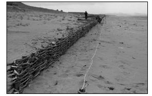
写真 4 防浪砂堤設置状況(2列目設置前) (写真:庄内総合支庁森林整備課)
