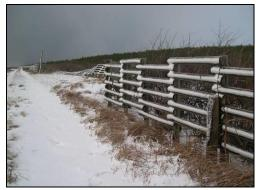
写真66 突風による木製防風柵の倒壊 写真67 同左 国有林1134 林班 赤川河口北700m地点 2006.1.3 発見、撮影 (写真:梅津勘一) 2005年12月25日の羽越線脱線事故を引き起こした突風の痕跡と推察される。 当地点から脱線事故をつなぐ直線上にクロマツの風倒木が列状に点在する。写真37、38参照。
