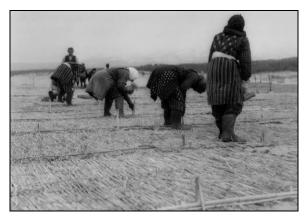
写真20 押串設置状況 ※
