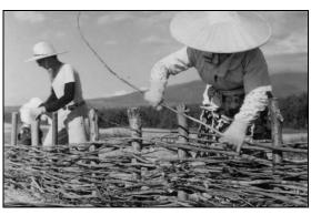
写真3 同左 編柵工 帯梢設置状況 ※
