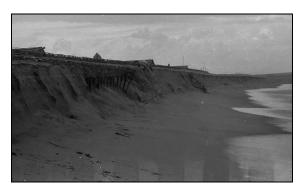
写真 6 高潮による防浪砂堤被災状況(遊佐町比子 1960 年代民有林治山) 写真 7 同左 1952~1966(S27~S41) 国有林事業と平行し、民有林治山事業(海岸砂地造林)が菅里、比子で行なわれた (写真:庄内総合支庁森林整備課)
