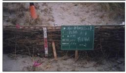
写真 1 編柵工施工例(写真:庄内森林管理署提供)
