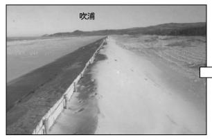
写真14 堆砂垣設置後の堆砂状況 ※ 写真15 同左 複数列施工後の堆砂状況 ※ 国有林 海岸砂地造林事業 1142 林班 (遊佐町十里塚北 1950 年代後半~60 年代前半)
