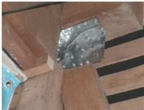
接合部の金物補強
