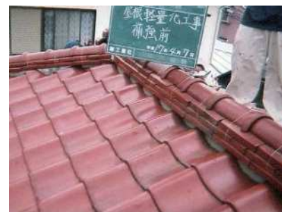
屋根の軽量化（瓦葺き から 金属板葺きに）
