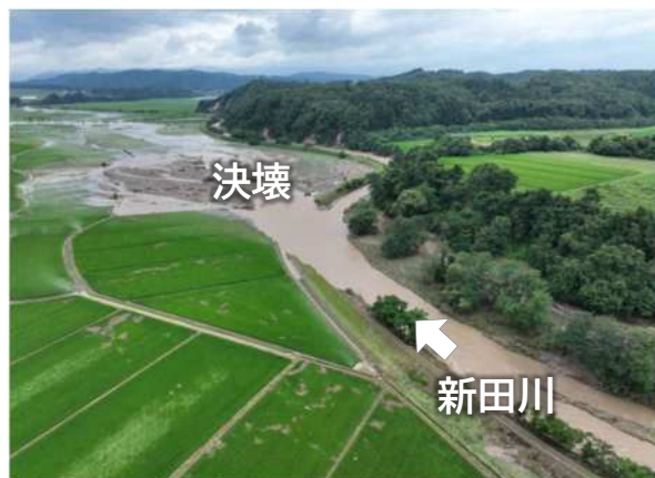
新田川 堤防決壊（新庄市）
