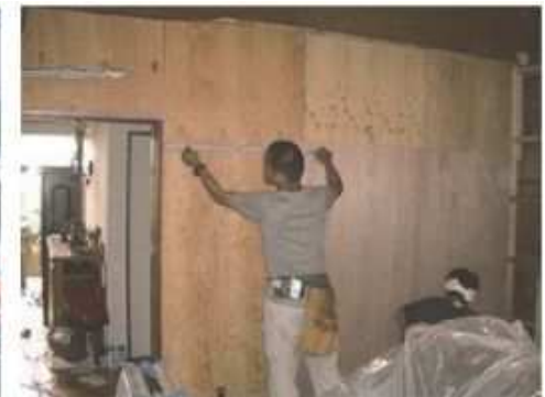
構造用合板による補強
