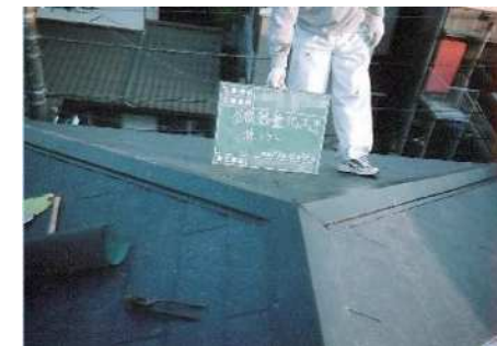
屋根の軽量化（瓦葺き から 金属板葺きに）
