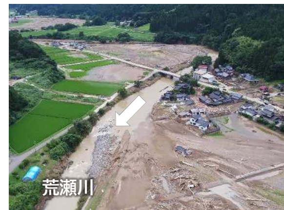
荒瀬川 浸水被害（酒田市）
