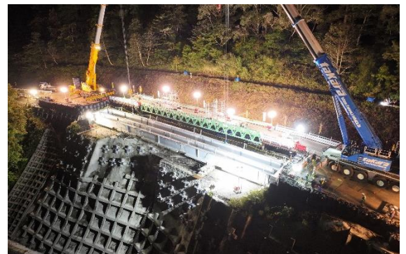
夜間工事のイメージ (令和6年10月撮影)
