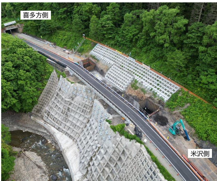
復旧工事の状況 (令和7年6月6日撮影)
