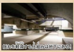
免震装置は巨大な地下空間に設置。地震のあとにも医療を続けられるように免震装置が建物の揺れを軽減します。
