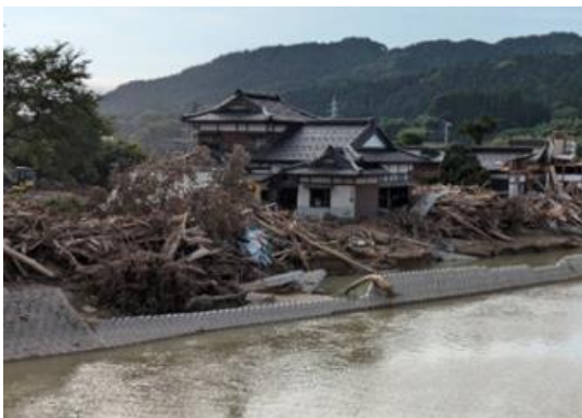
荒瀬川氾濫・住宅損壊状況（酒田市下青沢）
