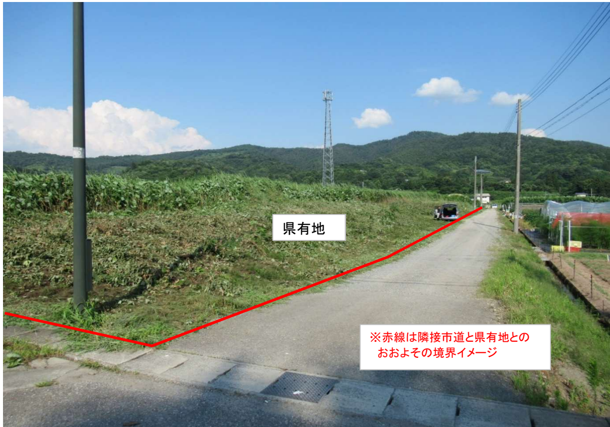
土地の南側法面 南西角から東方向を撮影
