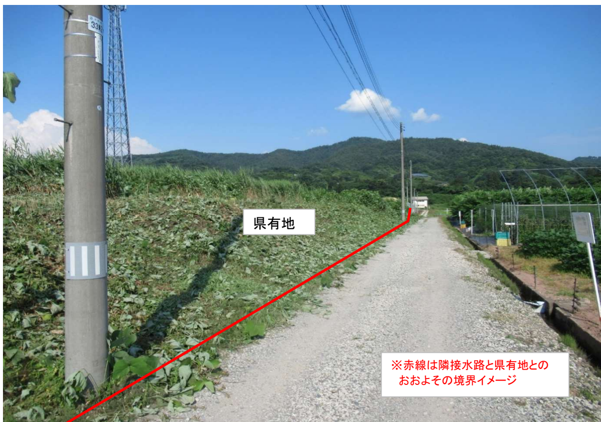
土地の南側法面 中央付近から東方向を撮影
