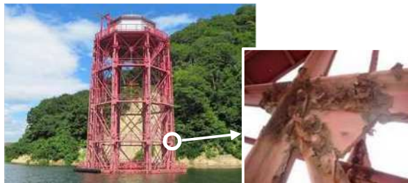
大規模で高度な技術による本格的な改修が必要な施設 S54 造成 犬川黒川取水塔 (飯豊町)
