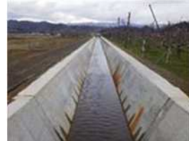
水路の改修状況
