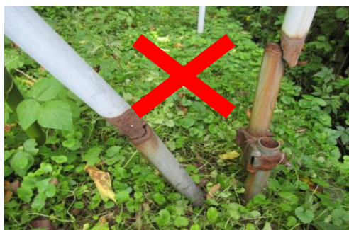
さびて折れたパイプ、さびたクランプ
