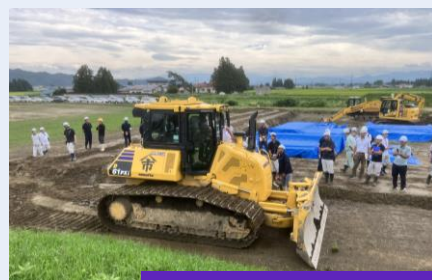
長井市草岡4期地区 MCブルドーザ
