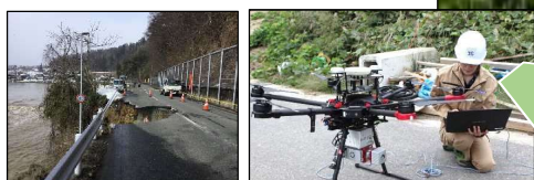
被災箇所の点群データを取得
