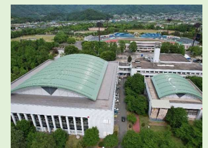
屋根改修(R6完了)
