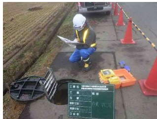
管路点検(マンホール点検)
