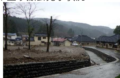
▼土砂撤去完了状況
