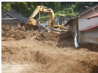
▼土砂撤去状況
