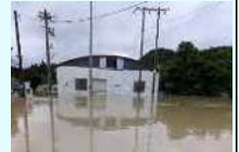
R8.7月豪雨におけるポンプ場冠水状況
