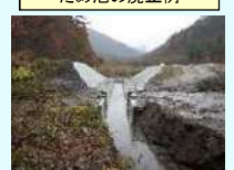
【高畠町】ため池の堤体を開削し、貯留機能を廃止
