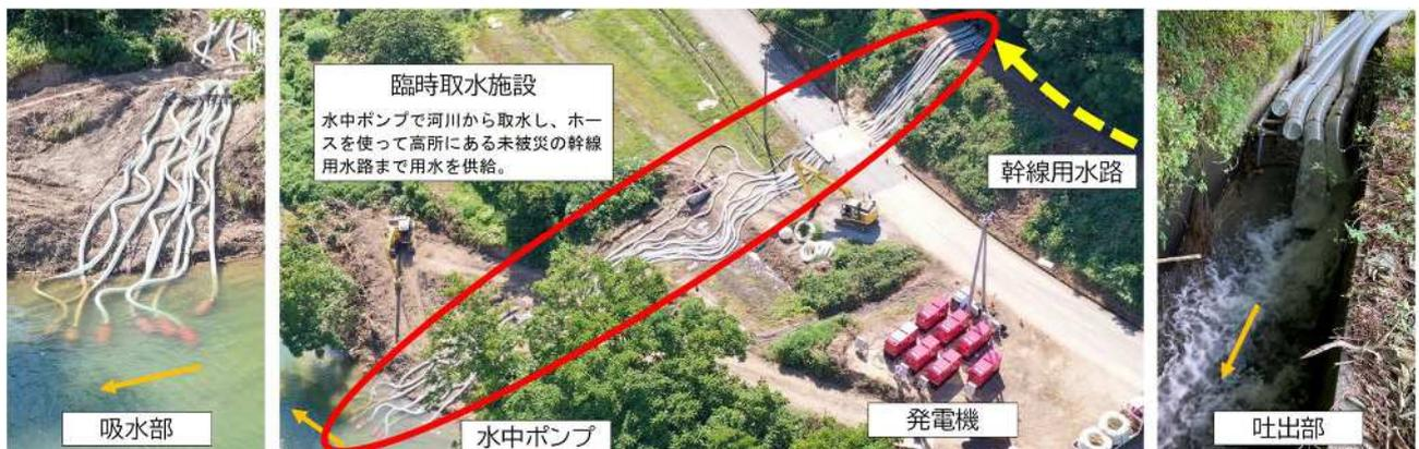
応急ポンプの設置による水路への用水供給状況（舟形町長沢地内）
