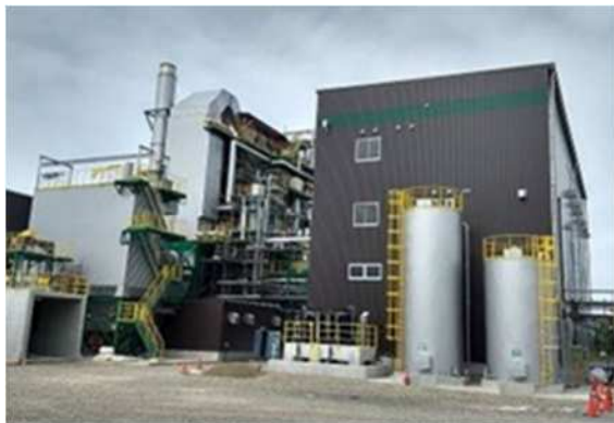
木質バイオマス発電施設
