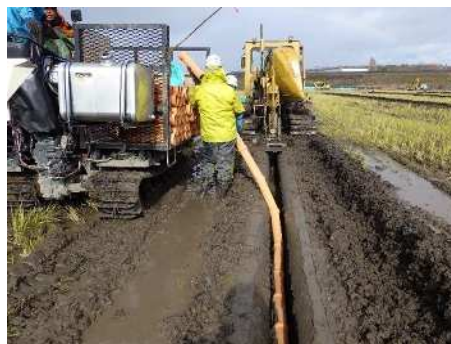
川西町 地下かんがいの施工
