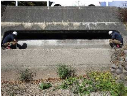
ため池施設状況調査
