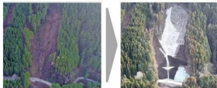
崩壊山腹において、下流への被害の防止・軽減を図るため法面保護工等を実施 (大分県日田市)
