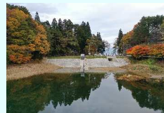
ため池の改修例
