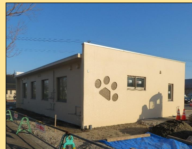
(仮)外観写真 R7.3.10現在
