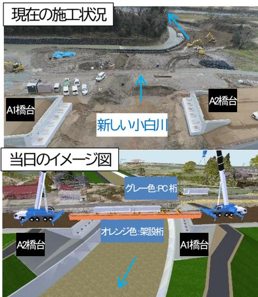
※A1橋台とA2橋台の間にあらかじめ据え付けた「架設桁」上に引き出した「PC桁」を、大型クレーン2台で架設します。
