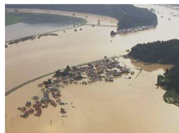
令和6年7月豪雨で氾濫した最上川 (出典: 国土交通省東北地方整備局)
