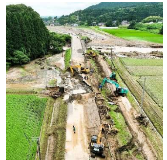
大雨災害からの復旧工事
