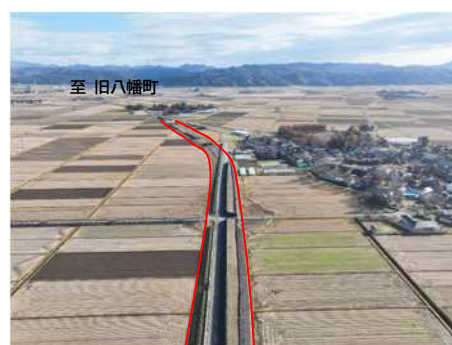
国道 344 号（安田 BP）
