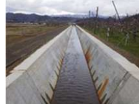
水路の改修状況
