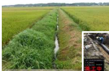
整備前(開排水路)
