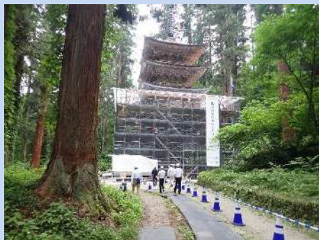
国宝 羽黒山五重塔（鶴岡市） ※令和6年9月修理完了
