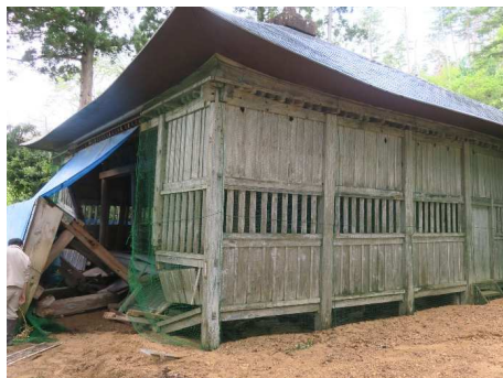
文化財保存修理 (天養寺観音堂・ 飯豊町) ※R4大雨で被災、 R6～7で修復
