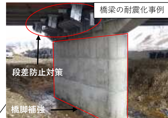
国道458号（升形橋）
