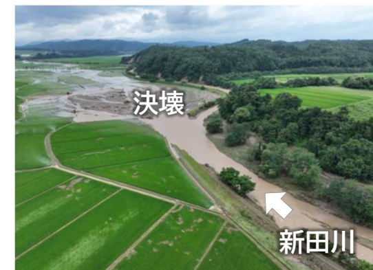
新田川 堤防決壊（新庄市）
