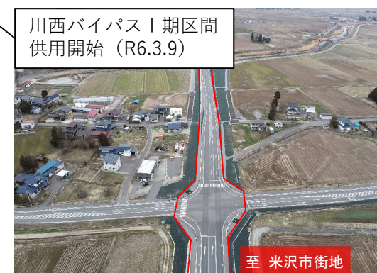
国道287号（米沢長井道路）
