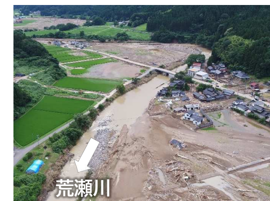
荒瀬川 浸水被害（酒田市）
