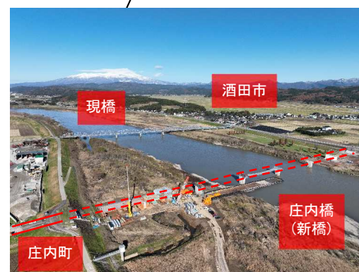
(一)余目松山線（庄内橋）
