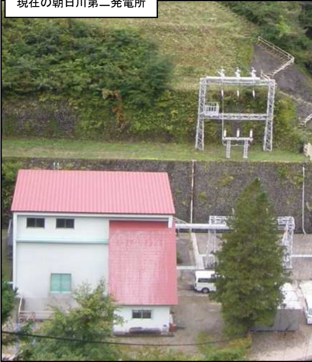
現在の朝日川第二発電所
