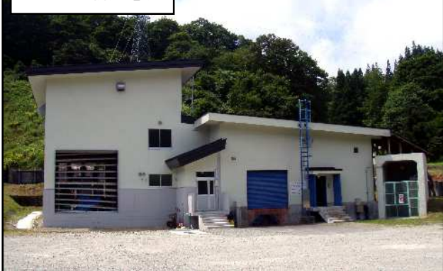
現在の肘折発電所
