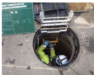
管路点検(管渠目視点検)
