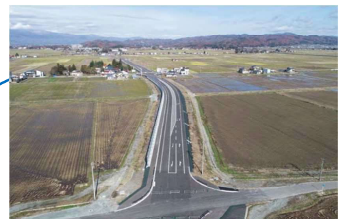
川西バイパス開通(川西町)
