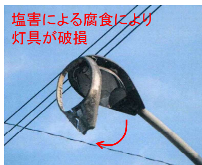
照明灯更新前
