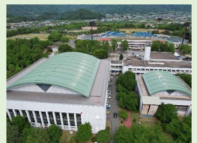
屋根改修(R6完了)
