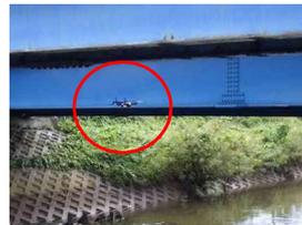
▶ UAV(ドローン)による点検
