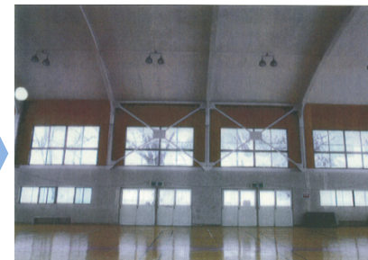
▲ 鉄骨ブレースの設置
