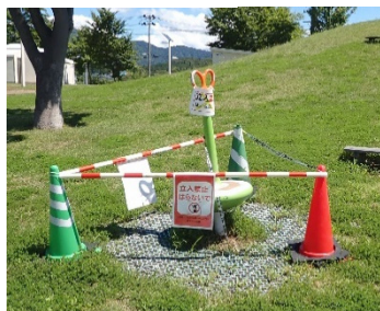
▲老朽化により修繕が必要となった遊具
