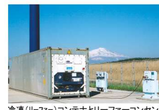
冷凍(リーファー)コンテナとリーファーコンセント 220V*2/440V*10 電源設備使用料 31円/kwh
