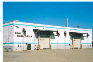
面積 618㎡ 加温あり 西ふ頭くん蒸施設
