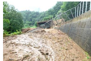
国道344号 法面崩壊（真室川町）
