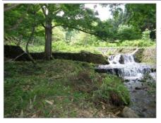
崩下流堰堤の 420m下流に位置します。堤長 29m、堤高 1.7mの練積で築かれた重力式堰堤で、下流側法勾配は 3 分としています。渓流最下流に立地し、水通し幅は 18mと広くとっています。他の堰堤と同様に堤体法面を急勾配で築いた砂防堰堤としては、全国的に初期の事例です。
