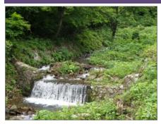
中沢川の上流狭窄部に築かれた砂防堰堤です。堤長 12m、堤高 2.4m、 練積による重力式堰堤で、湾曲して流れる川の土石流を右岸上流側の 空積護岸とともに受けます。大正 2 年の水害後に建設された県内初の 県営事業による近代砂防施設です。
