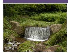
崩上流堰堤から直線状に延びる流路の 70m下流に位置します。堤長 15m、堤高 3.4mの練積による重力式堰堤です。堤高の低い堰堤を連続的 に築くことで、急峻な河床勾配を段階的に緩和して河床を安定させ、 周囲の緑の回復に寄与している。
