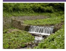
東山堰堤の 180m下流に位置します。堤長 14m、堤高 1.9m、練積で築かれた重力式堰堤です。堤体は谷積で築き、水通しの両袖部には丸みを付けています。両岸の斜面法尻には、全長 212mの空積護岸を築いて流路を安定させています。山間部の穏やかな渓流景観をつくっています。
