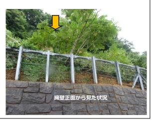
写真 3.1-6 擁壁による斜面崩落土砂の捕捉状況(鮭川村下牛潜地区:平成 30 年 8 月 31 日 )
