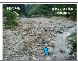
写真 3.1-5 砂防えん堤の土石流捕捉状況(白鷹町高玉地区:平成 25 年 7 月 18 日 )
