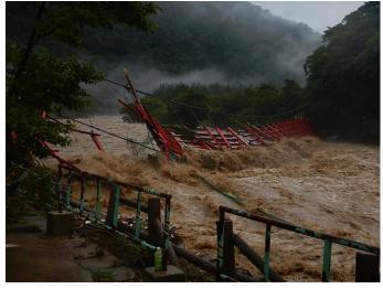
写真 2.3-2 8月31日 戸沢村蔵岡地区の浸水状況(左)と最上小国川のつり橋崩壊状況(右)
