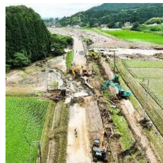
大雨災害からの復旧工事
