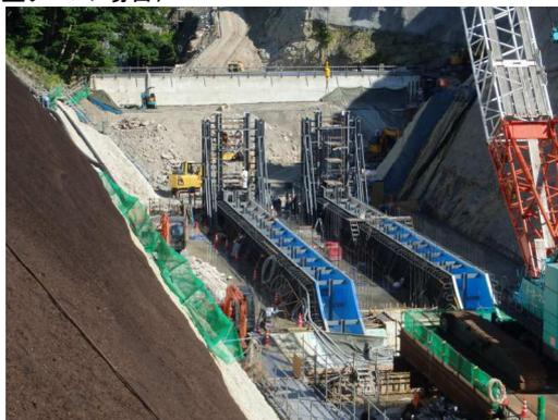
普段はダムに水は貯まらず、「洪水吐き」(青い部分)と呼ばれる部分を通してそのまま下流へ流れていきます。
