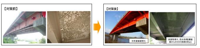
図 15 (主) 鶴岡羽黒線 羽黒橋 (L=294.1m 昭和49年架設)
