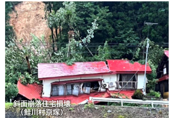
砂防被害状況
