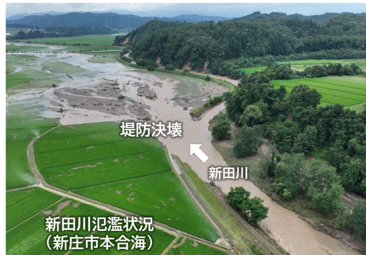
河川被害状況
