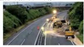
九州道で法面崩落が発生した際、4車線のうち被害のない 2車線を活用し、約8時間で一般車両の下り線の通行を確保(約19時間後には一般車両の上下線の交通機能を確保)
