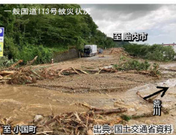
一般国道113号被災状況
