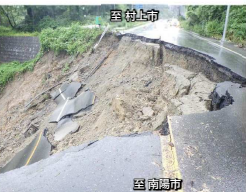
国道113号(山形県飯豊町手ノ子)
