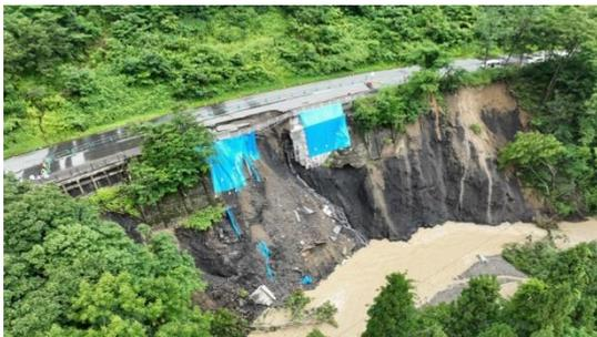
図 3-19 国道 121 号 道路崩落(令和 4 年度)
