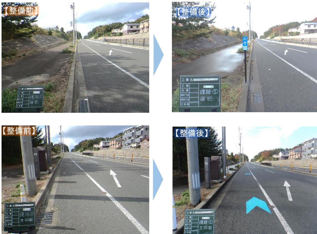
図 3-15 自転車通行帯の整備例(上:自転車案内標識の設置、下:矢羽根マークの表示)
