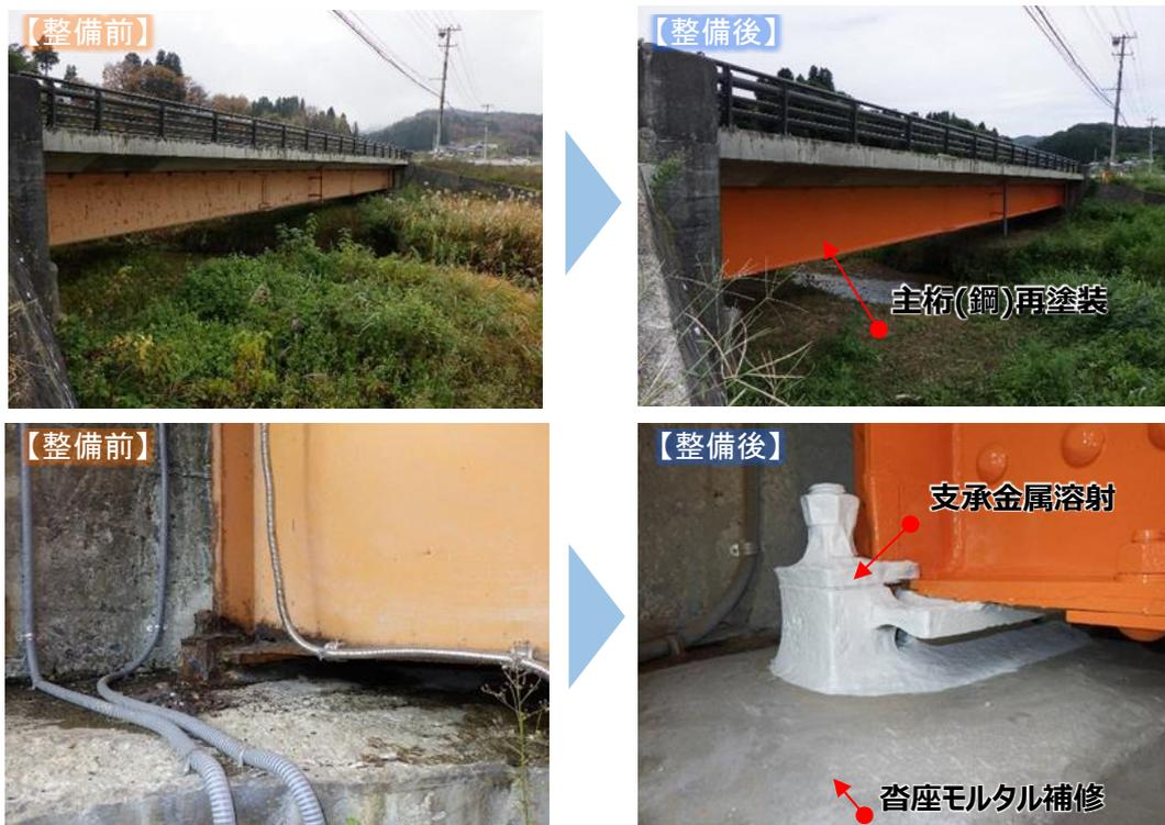
図 3-11 橋梁長寿命化対策例(上:主桁(鋼)の再塗装、下:支承金属溶射、沓座モルタル補修)
