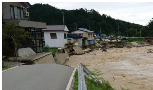
図 3-21 (一)片倉塩線 道路崩落(令和 2 年度)
