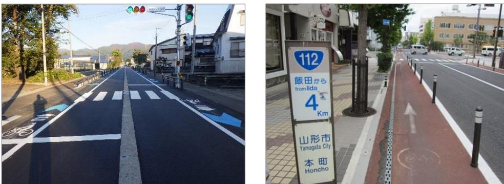
図 1-59 自転車通行空間の整備事例(左:車道混在、右:自転車専用通行帯)
