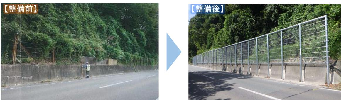
図 3-8 落石防止対策の事例(落石防護柵の設置) (主)天童大江線(大江町左沢楯山)
