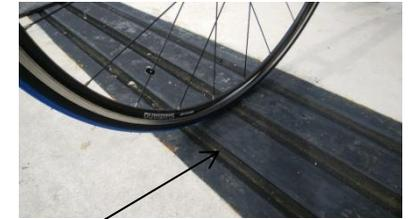
横断方向の狭い溝のみの構造にすることで安全性・走行性が向上する。
