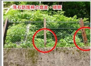
落石防護柵の腐食・破断
