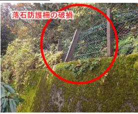
落石防護柵の破断
